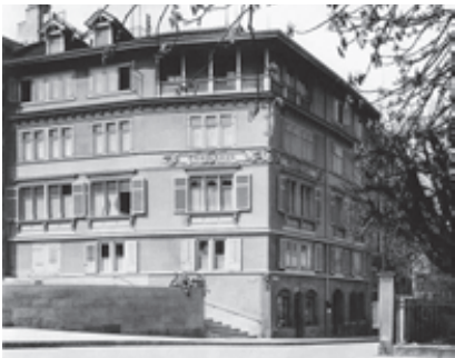
Hauptsitz der Schweizerischen Rentenanstalt von 1876 bis 1899. «Chamhaus», Obere Zäune in Zürich.
