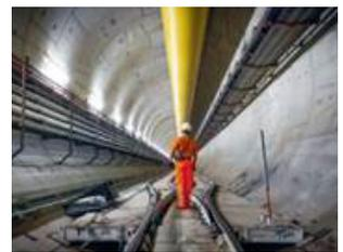
Long de 25 km, le Thames Tideway Tunnel recueille les eaux usées qui se déverseraient sinon dans la Tamise et les transfère à une station d'épuration.
