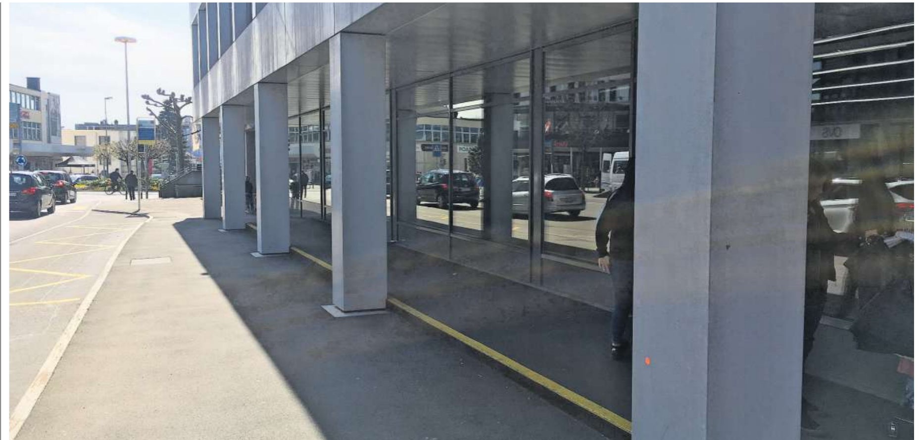
Diese Räume in der Liegenschaft Freihof standen seit der Wiederöffnung im Herbst 2014 leer. Nächstes Jahr wird die Migros-Bank einziehen.
