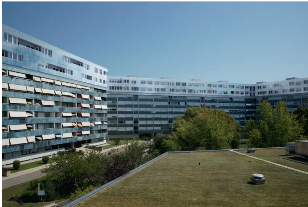
Verdichtung mittels Aufstockung im Kanton Genf
